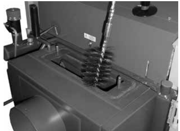
Vorführung der Reinigung des Rauchkanals mit Drahtbürste.
