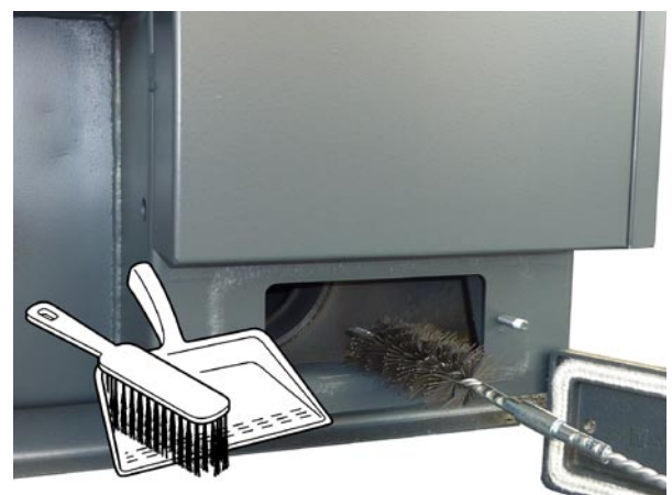
Vorführung der Reinigung des Rauchkanals mit Drahtbürste.
