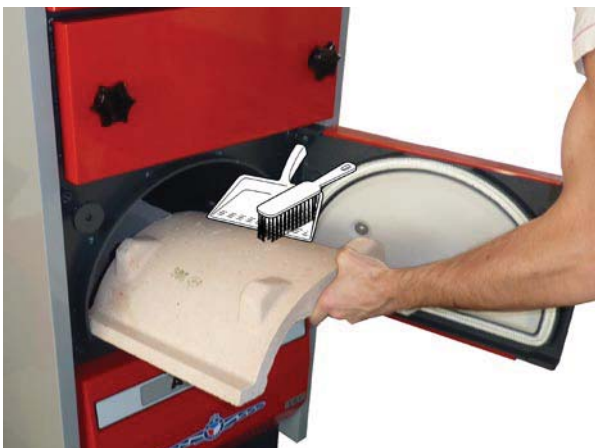
Reinigung des keramischen Verbrennungsraumes - Zylinders
