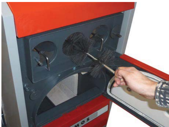
Reinigung des Wärmetauschers (Rohrwand) mit der beigelegten Bürste (bei den Kesseln D20P, D30P und D45P)
